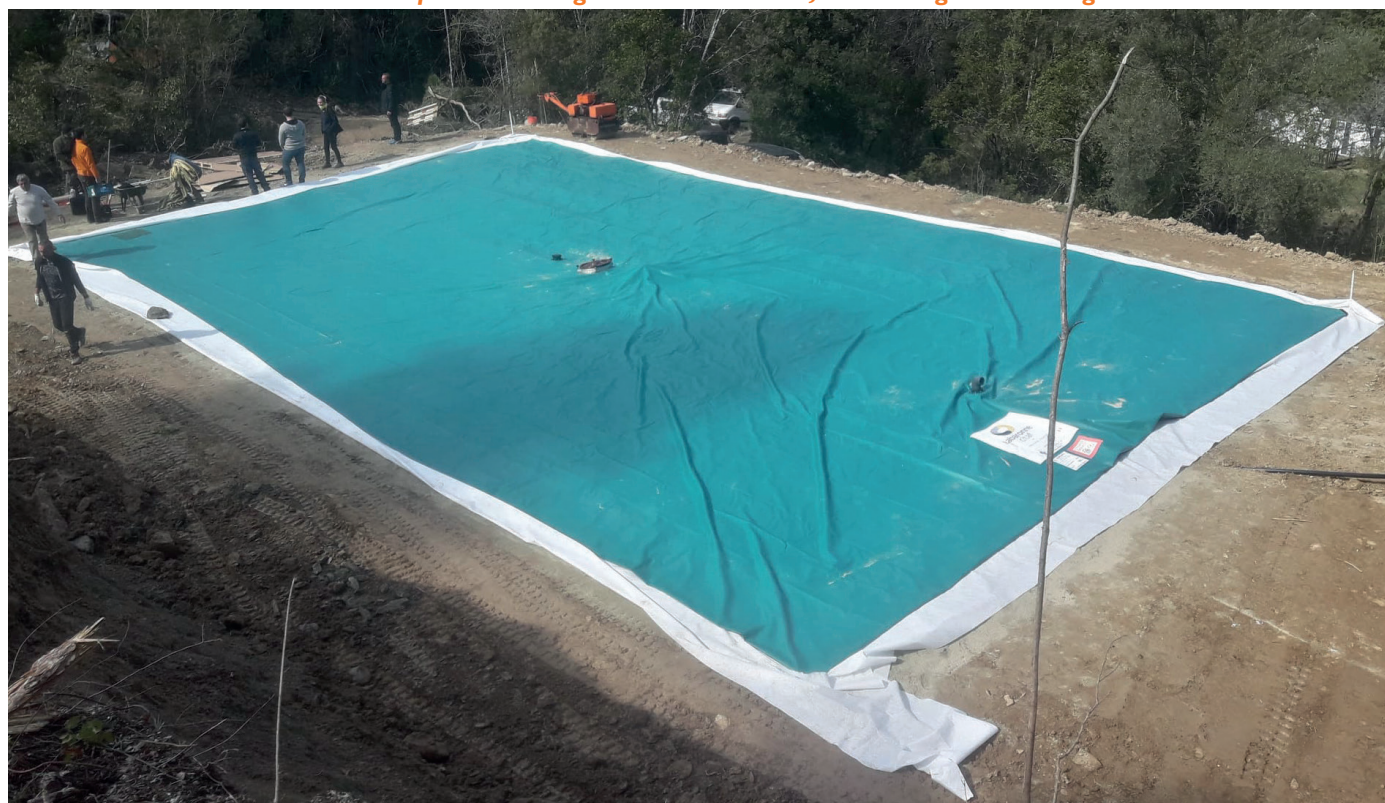
Exemple de réalisation, optimisation de la ressource en eau : citerne souple de stockage de 300 000 litres, maraîchage de montagne
